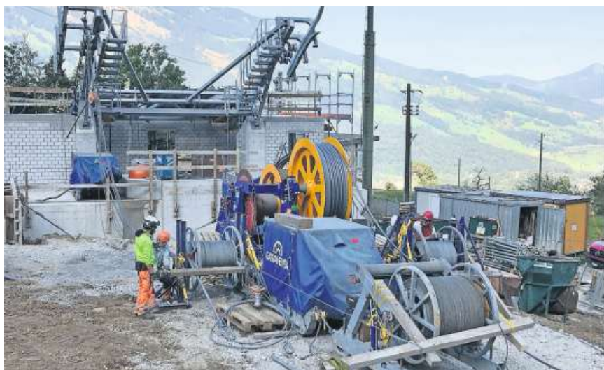
Gute Teamarbeit ist die Grundvoraussetzung, um präzise arbeiten zu können. Im Hintergrund erkennt man den Baufortschritt der Station Kräbel. Bild: Rita Baggenstos
