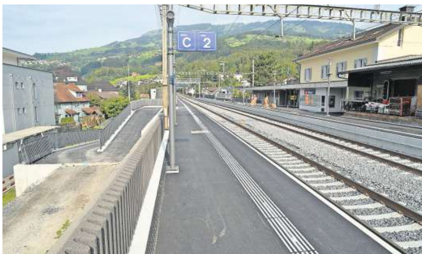
Ebenfalls neu und angepasst ist der Ausgang auf der Frauholzseite beim Gleis 2. Der Ausgang ist kinderwagen- und rollstuhltauglich. Auch der Perron wurde erhöht.
