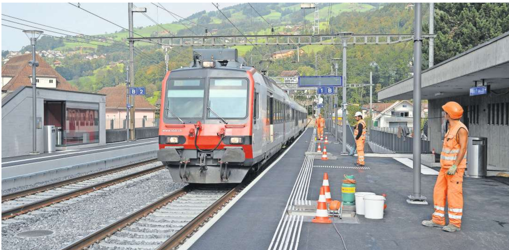
Das Perronniveau wurde erhöht und übersichtlich gestaltet. Jetzt kann in Steinen hindernisfrei in die Züge ein- und ausgestiegen werden.
