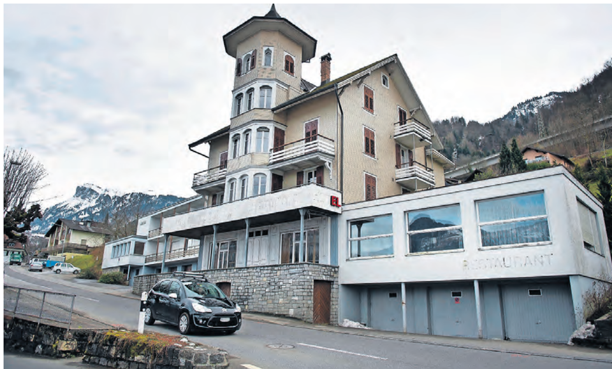
Die Tage sind gezählt: Wo heute noch das «Edelweiss» steht, entstehen vier Mehrfamilienhäuser.
