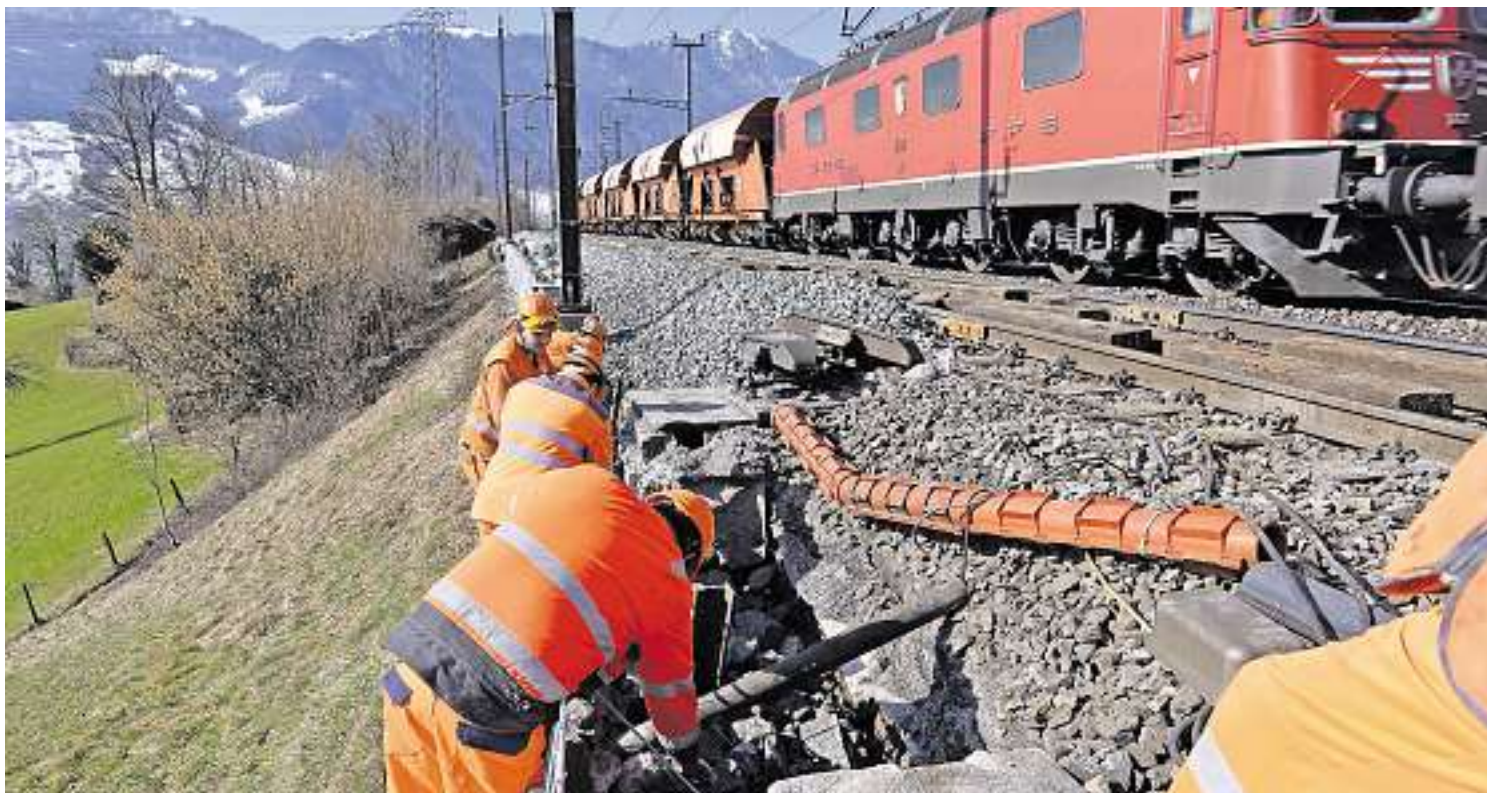
Mitarbeiter der Firma Vanoli bauen hier bei Steinen erneuern die SBB Schienen, Schwellen und Schotter. Holzschwellen sind neu auf dem Abstellgleis. Bild Erhard Gick
