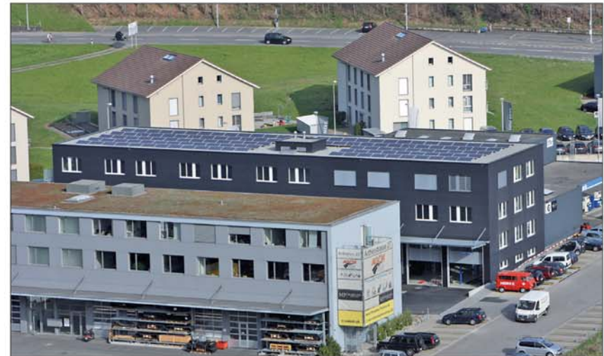
254 Solarmodule produzieren auf dem Dach des Gewerbegebäudes in Immensee erneuerbare Energie.
