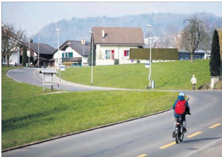
Soll bald überbaut werden: die Wiese zwischen dem Baarer Ortsteil Inwil und dem Gebiet Arbach.
