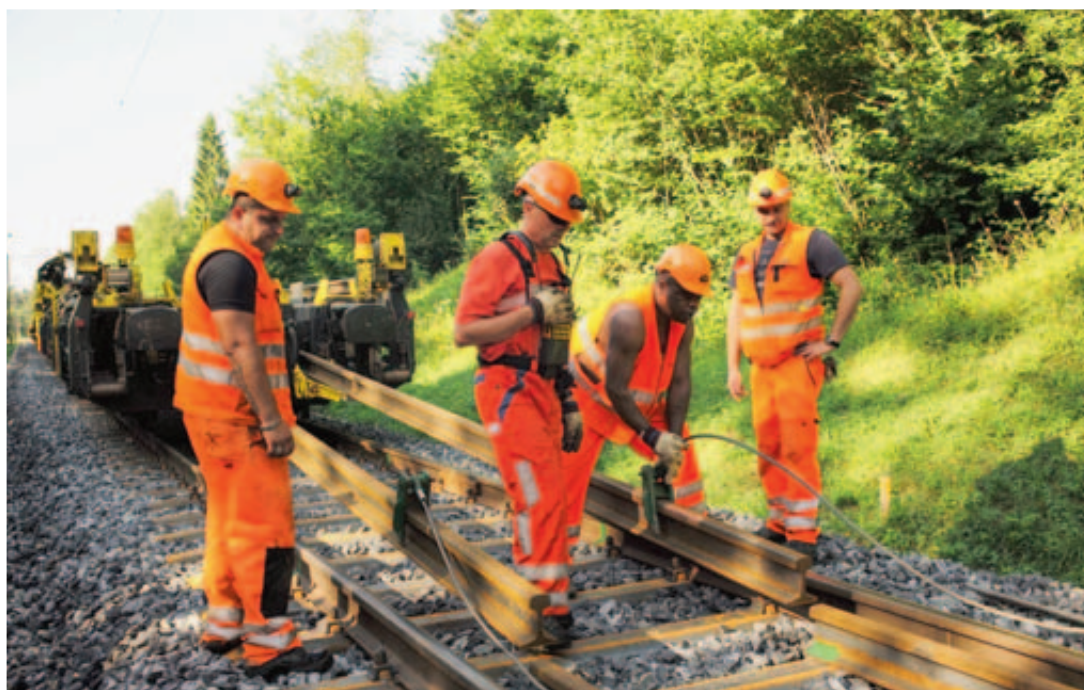
Entre Montmollin et Les Geneveys-sur-Coffrane, la machine décharge les rails qui se posent sur la voie comme de longs spaghettis. Ils seront fixés définitivement de nuit, quand la température aura passé sous les 25 degrés.
