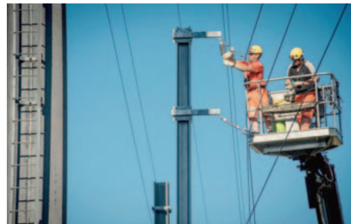
D'ordinaire, le remplacement des caténaires ne peut se faire que de nuit, quand il n'y a pas de trains. A Saint-Blaise, la fermeture totale du tronçon permet de faire ces travaux de jour. Rare pour les employés du BLS!
