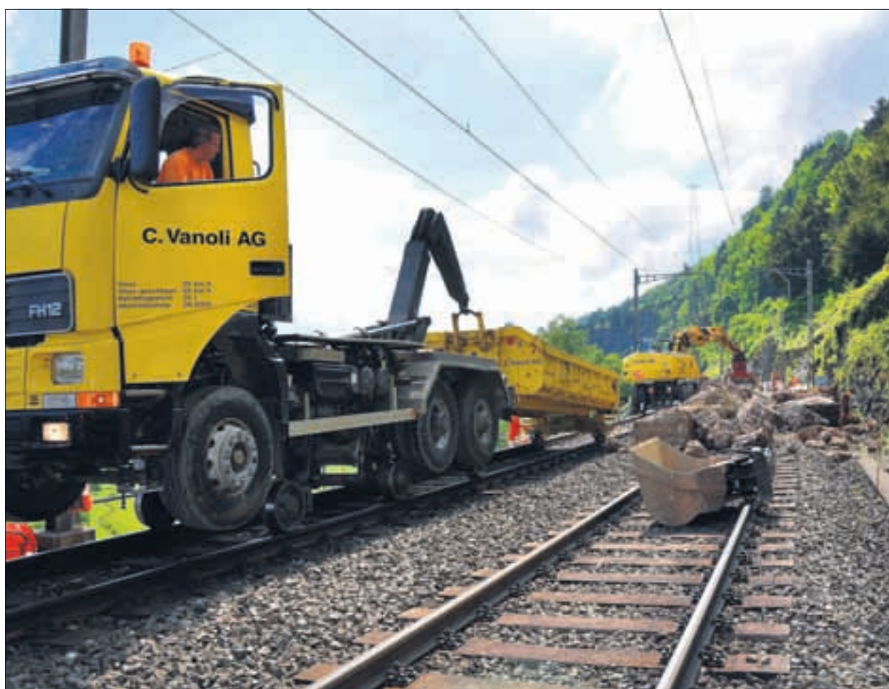
Bauarbeiter baggern die Schiene von den Felsbrocken westlich des Bahnhofs Goldau frei.
