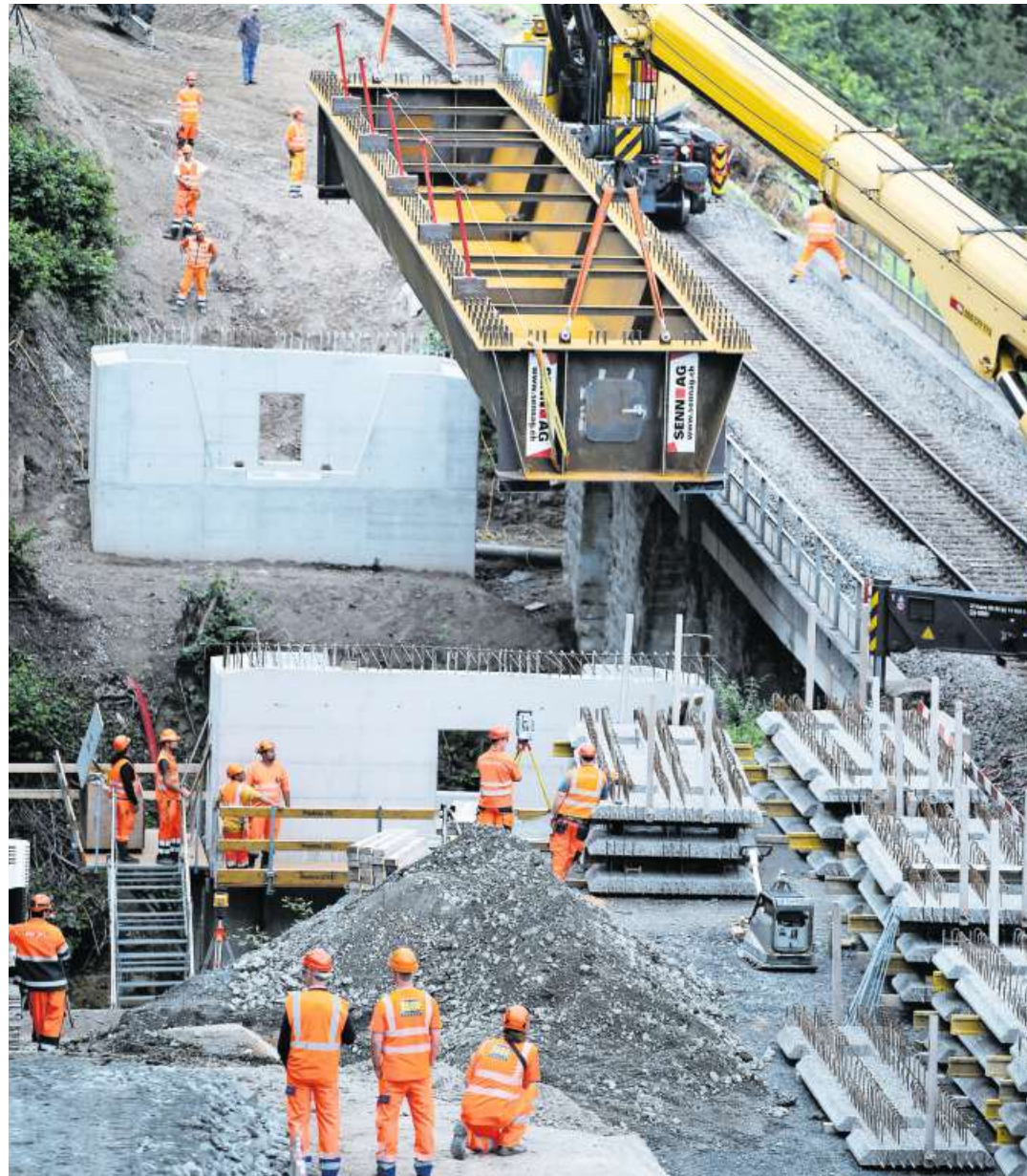
Im Bereich des Sagenbachs liegen mittlerweile zwei Gleise. Am 13. Dezember am frühen Morgen verkehren auf den beiden Brücken die ersten fahrplanmässigen Züge. Bild: Stefan Kaiser (Walchwil, 9. Juli 2019)
