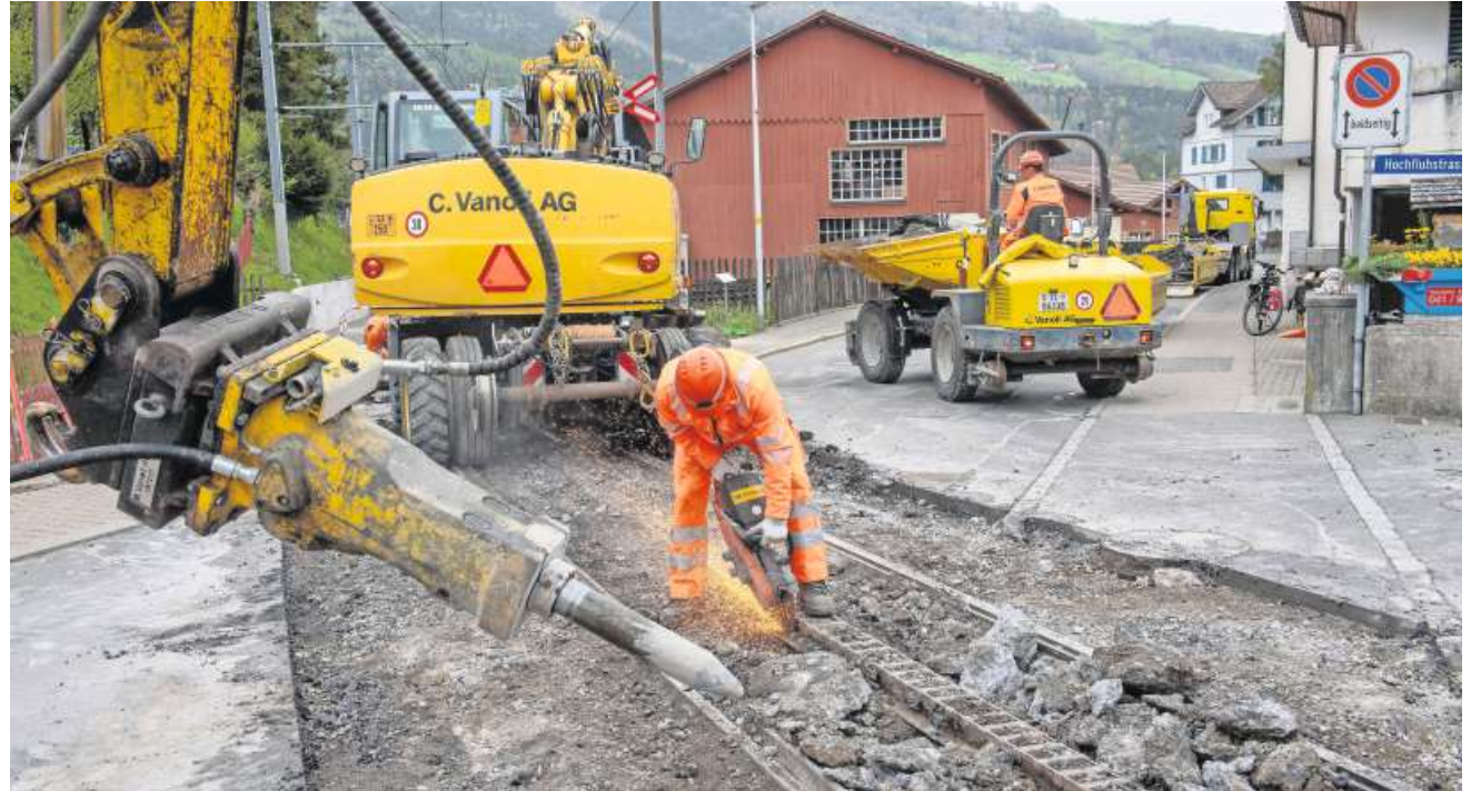
Die Verankerungen der freigelegten Geleise werden mit einer Trennscheibe herausgeschnitten.
