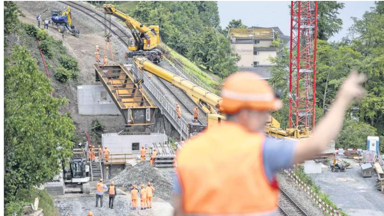
Am Zugersee-Ostufener wird fleissig gebaut.
